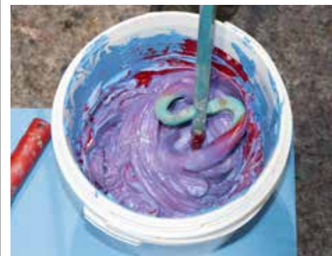
Mischen der Flüssigfolie bis homogene Farbe entsteht
