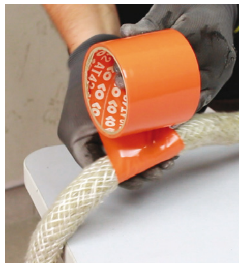
Nullifire FJ203 abkleben, um das Zuschneiden zu erleichtern
