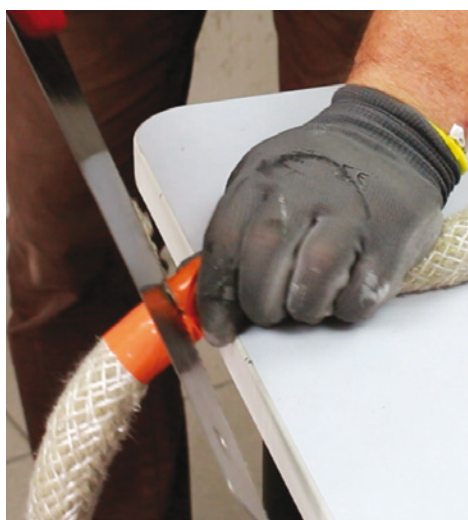
Nullifire FJ203 zuschneiden
