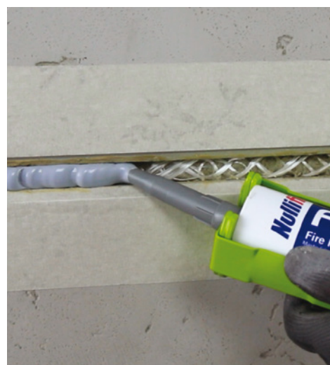
Fuge kann anschließend je nach Wunsch mit einem geeigneten Dichtstoff (z. B. Nullifire FS702, FS703 oder illbruck SP525) versiegelt werden
