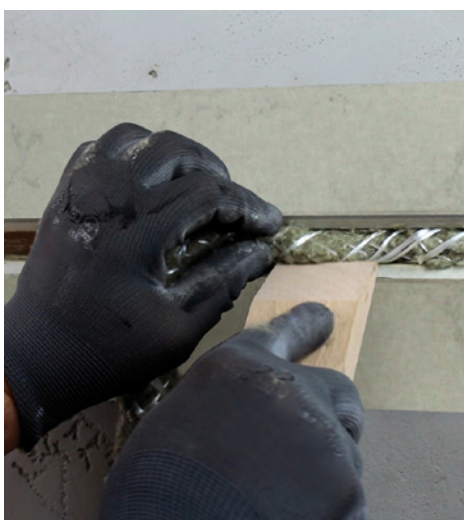
Nullifire FJ203 in Fuge einbringen
